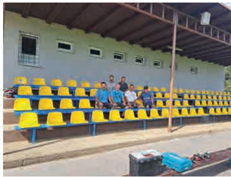
Rekonštrukcia tribúny na športovom štadióne
